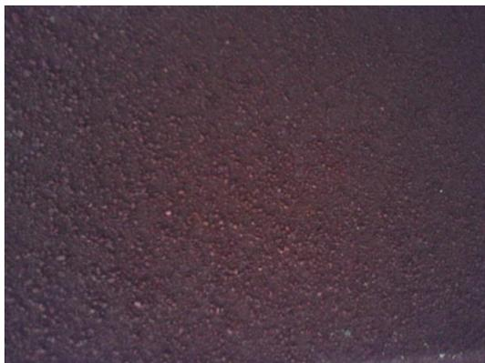
Gambar 4.4 : tekstur atap dengan lapisan pasir kasar
